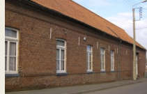
29 - Ferme à cour carrée
